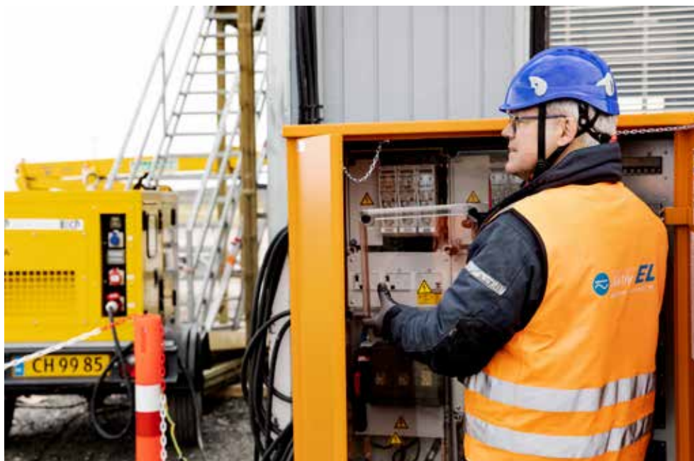
Dieselgeneratorer sørger for byggestrøm, indtil kablerne er lagt i jorden.
